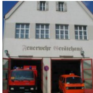
Gerätehaus bis 2005 mit LF8/6 und Messfahrzeug des Landkreises
